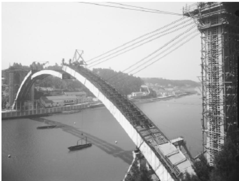
Fig.34 – Elevação do tramo central do cimbre metálico
