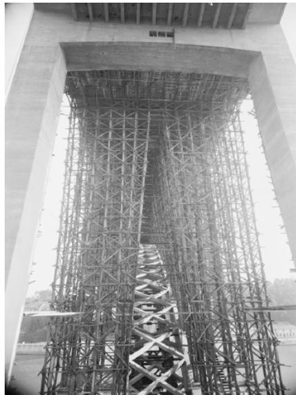
Fig.37 – Fase de betonagem dos pilares e tabuleiro sobre o arco (Centro Português de Fotografia – Casa Alvão)
