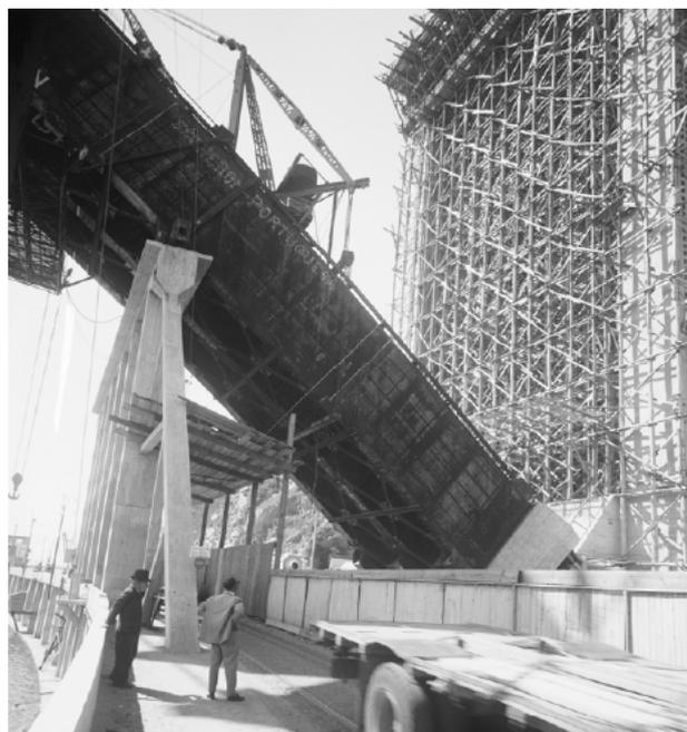
Fig.33 – Montagem do cimbriço com grua *derrick* sobre o cimbriço, apoiado em pórtico provisório
