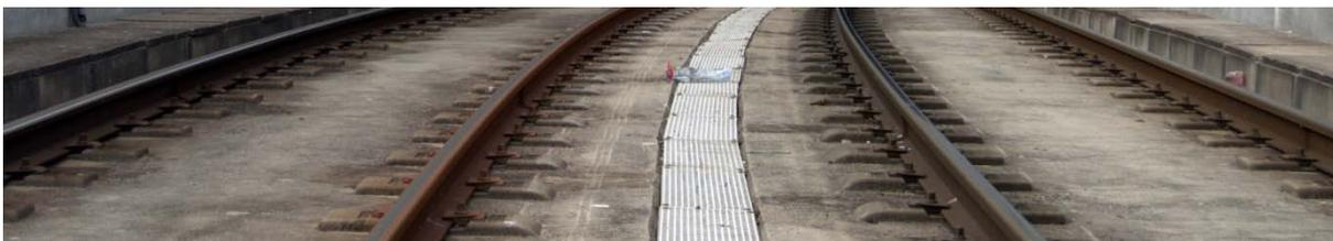
Fig.88 – Via betonada nos acessos à Ponte Luiz I na margem do Porto
