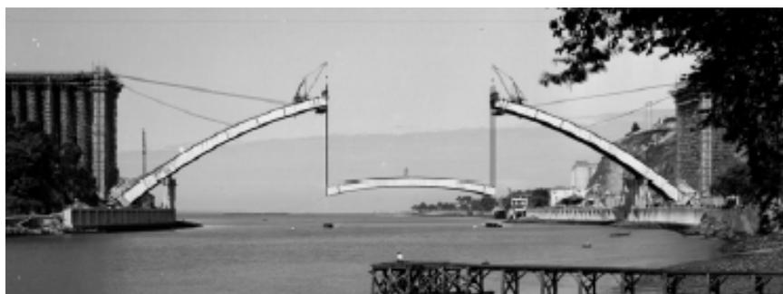
Fig.35 – Elevação do tramo central do cimbre metálico
