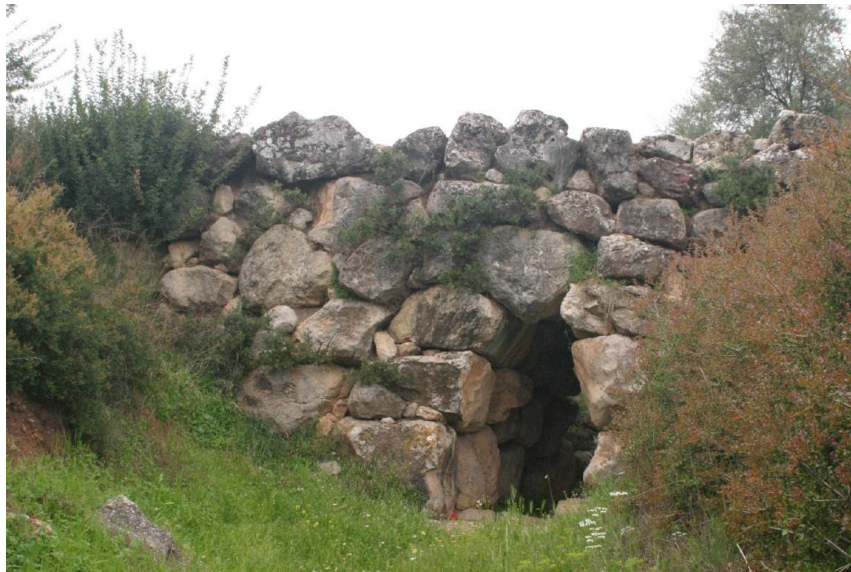
Fig. 2 – Ponte de Kazarma – Atenas (David, 2006)
